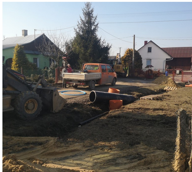
BUDOWA KANALIZACJI SANITARNEJ W DYMITROWIE MAŁYM.
