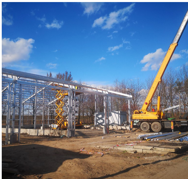
BUDOWA ZADASZENIA POLETKA OSADOWEGO – OCZYSZCZALNIA ŚCIEKÓW W BARANOWIE SANDOMIERSKIM.
