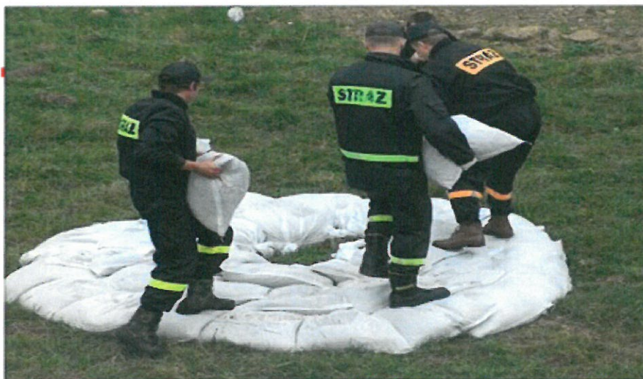
Spiralne układanie worków od gruntu stabilnego do środka przebicia
